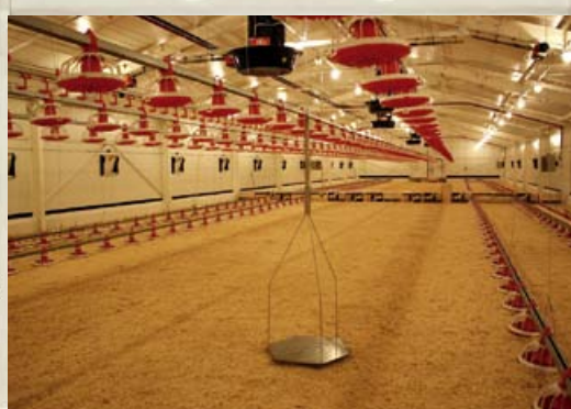
Szalka wisząca WGJ firmy Jotafan, która wraz ze sterownikiem-rejestratorem stanowi system automatycznego ważenia drobiu
