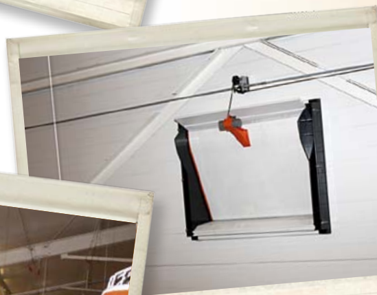
Wlot ścienny CL Flex z możliwością zróżnicowanego otwierania klapy
