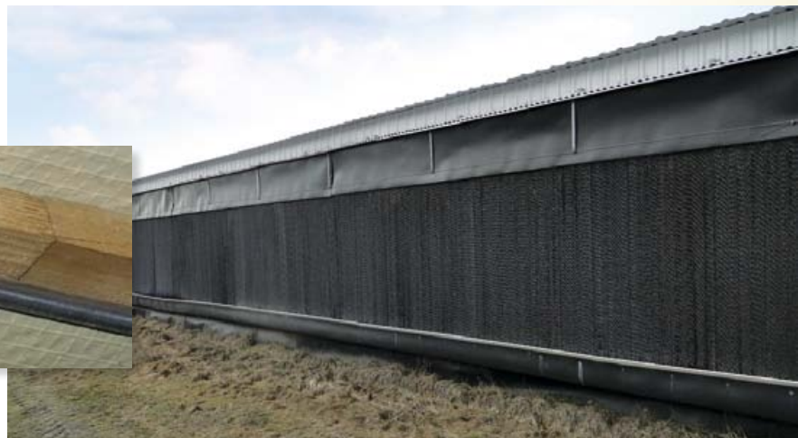
Panel ewaporacyjny, dzięki któremu schłodzone powietrze dostaje się do środka przez tunel wentylacyjny
