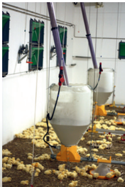
Część systemu wentylacji stanowią równomiernie rozłożone wloty ścienne powietrza z regulacją stopnia otwarcia klap
