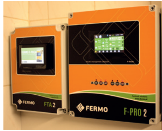
Elektroniczny sterownik z dostępem do komputera lub telefonu poprzez internet pozwala w nowoczesny sposób sterować klimatem w całym kurniku
