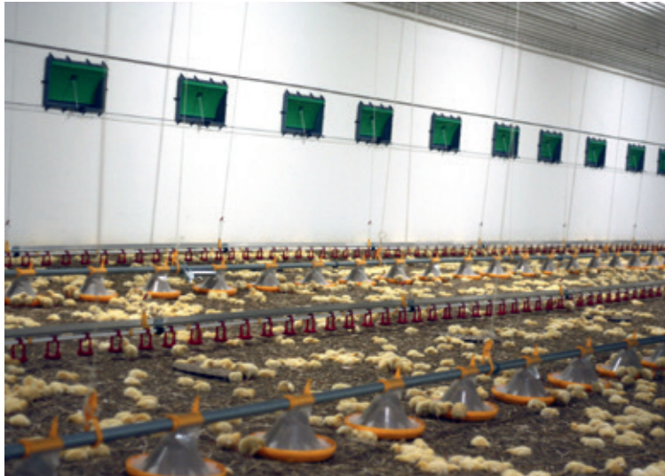
Część systemu wentylacji stanowią równomiernie rozłożone wloty ścienne powietrza z regulacją stopnia otwarcia klap
