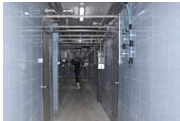
^ Ściany wszystkich pomieszczeń pokryte są płytkami w celu łatwiejszego utrzymywania czystości
