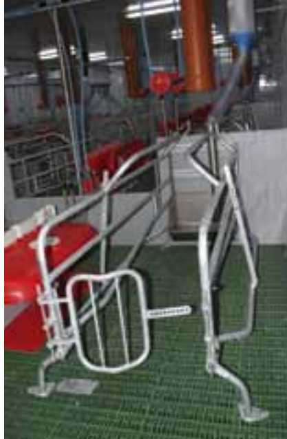
^ Nad głową każdej lochy na porodówce zamontowano doprowadzenie chłodnego powietrza - tzw. świeży nos
