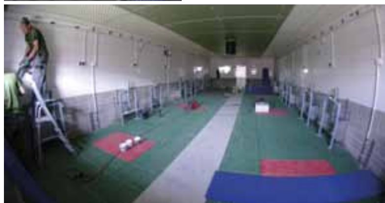
^ Porodówka w trakcie montażu ostatnich wygradzeń
